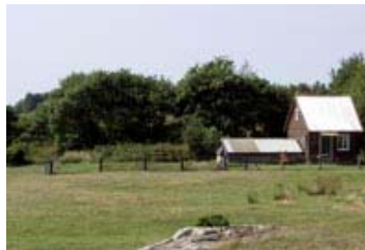
Annexet, Ståfelts eller Hönshuset 2005 sett från öster. En nyare stege till loftet skymtar till höger.
