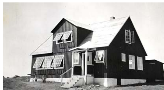
Hied på stenhuggarbarackens grund 1925. Fönstren är nymålade och takpannor saknas. Från Väderöklubbens album.
